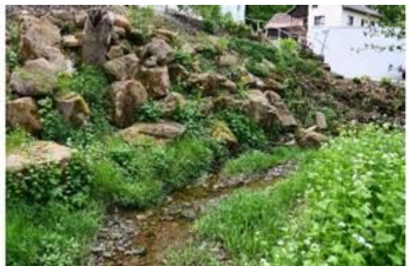
Abschnitt 14: Bach im Ortsbereich. Teilweise sehr steile Ufer mit harter Verbauung.
