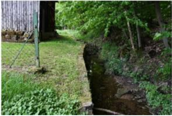
Abschnitt 14: Bach im Ortsbereich. Bach verengt mit Steilufer auf der einen Seite und harter Verbauung auf der anderen.
