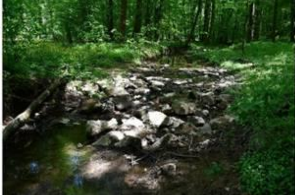
Abschnitt 1: Rampe oberhalb der Mündung in den Leuchsenbach. Nicht durchgängig.
