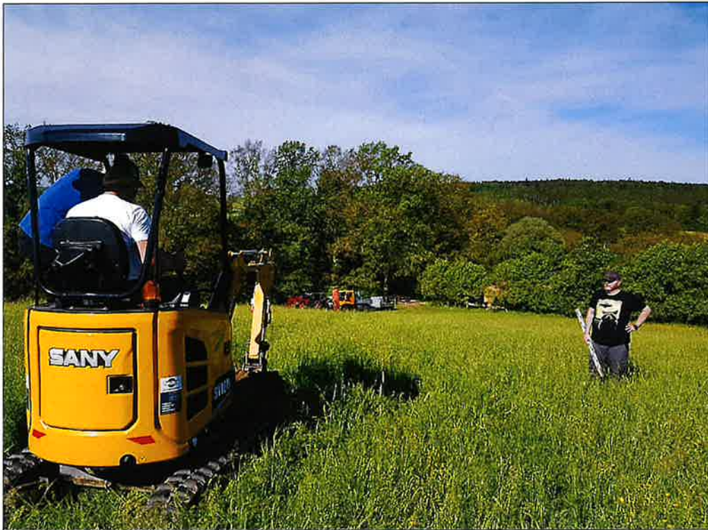
Bild 1: Westlicher Teil des Betrachtungsbereichs mit Blick auf die Zufahrt beim Versickerungsversuch 1.
