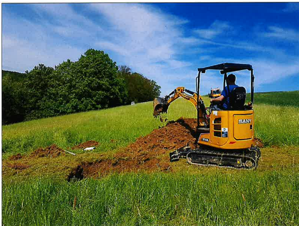
Bild 4: Aushub des Schurfes für den Versickerungsversuch 4, Blick nach Nordwesten.
